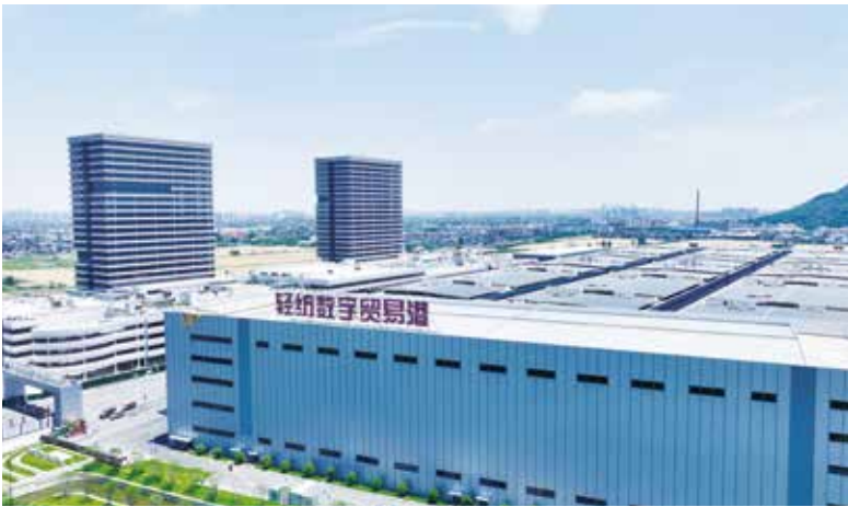
轻纺数字贸易港主体工程全面竣工。
